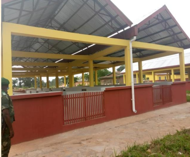
Espace à vivre, construit à Kabeya kamwanga
