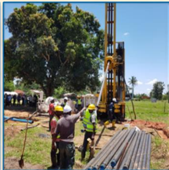
Travaux de forage encours
