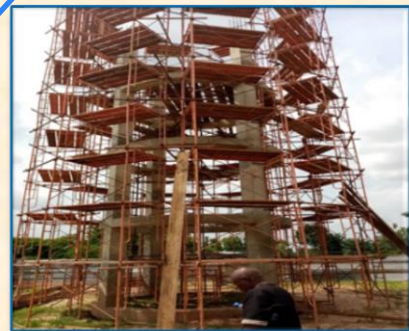
Châteaux d'eau encours de Construction Luandanda
