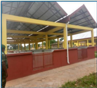
Espace à vivre, construit à Kabeya Kamwanga
