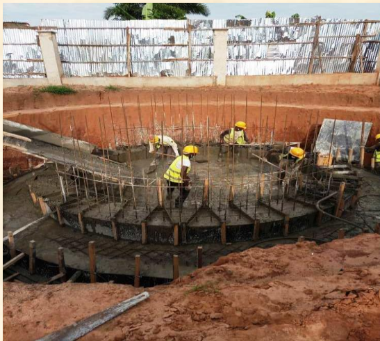
Châteaux d'eau encours de construction
